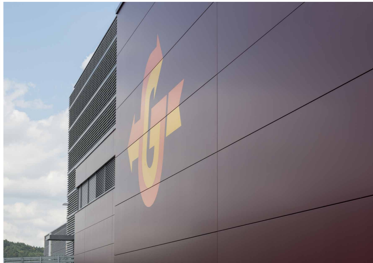
Montage von bis zu 8 m' langen QuadroClad Fassadenplatten: äusserst ebene und widerstandsfähige Paneele, die auch in Übergrössen hergestellt werden können.
