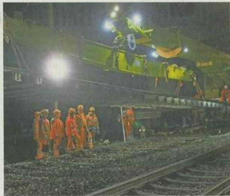
**Mehrteilig:** In vier Einzelteilen werden die einzelnen Gleiselemente angeliefert und versetzt.
