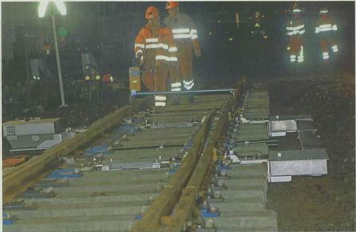
**Nivellieren:** Mit einem Lasergerät wird die Gleishöhe millimetergenau gemessen.
