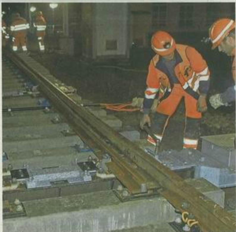
**Viel Elektromechanik:** Einstellen des Weichenmotors und der Steuerstangen.
